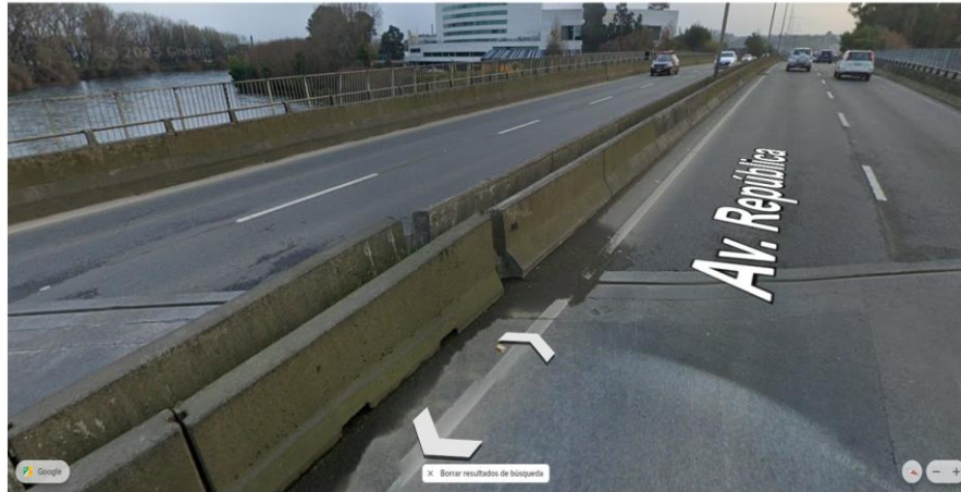
PUENTE SAN PEDRO NUEVO
