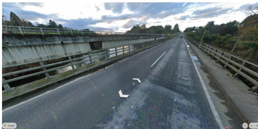
PUENTE RAHUE RUTA 5 SUR
