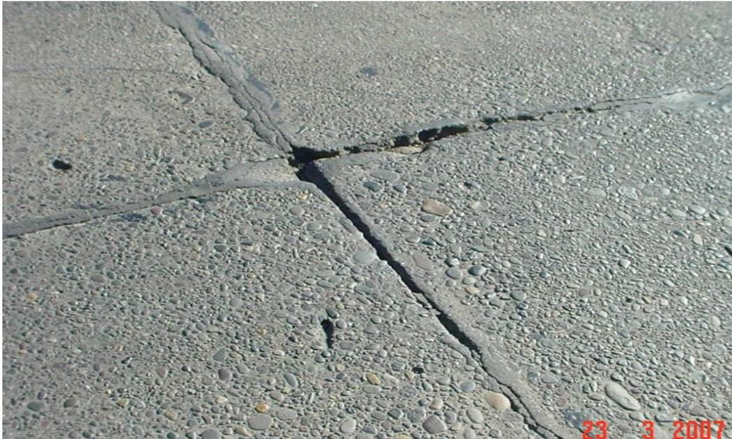
Pavimento existente en mal estado (Defectuoso estado de la juntas en losas, Presencia de Grietas y fracturas).
